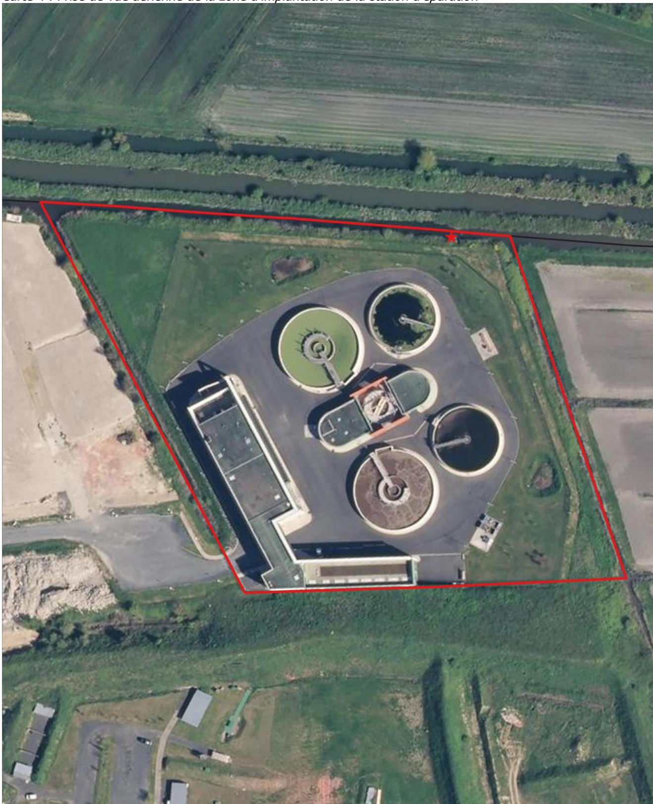
Carte 4 : Prise de vue aérienne de la zone d'implantation de la station d'épuration
