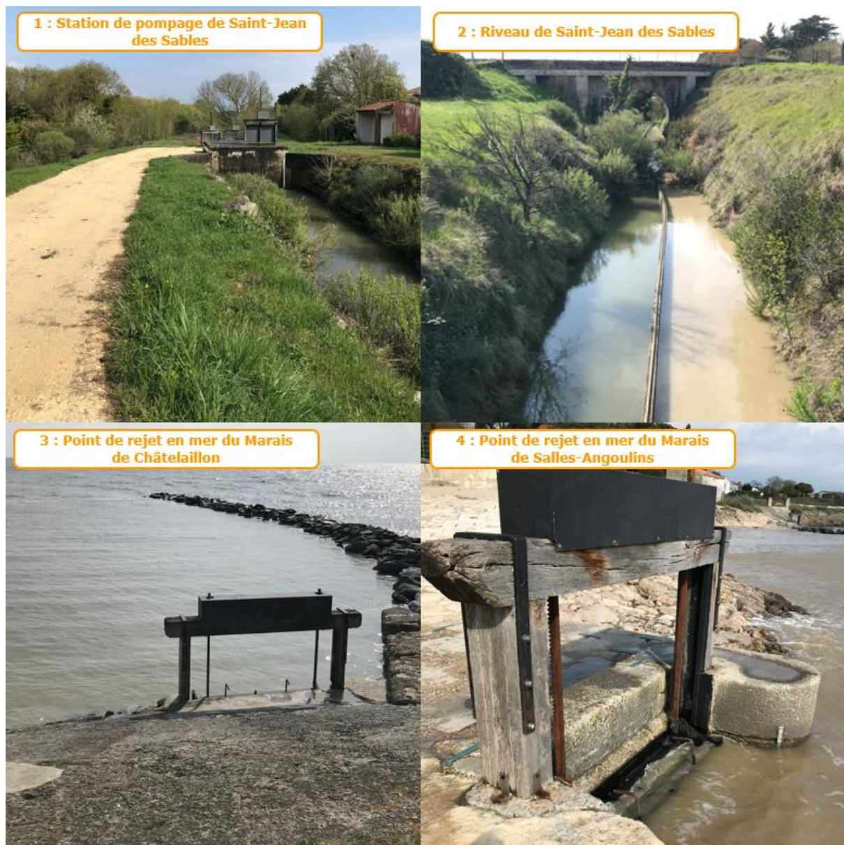
Figure 16 : Photographie des ouvrages constituant la station de pompage de Saint-Jean-des-Sables et des exutoires en mer du Marais de Châtelailion et Salles-Angoulins
