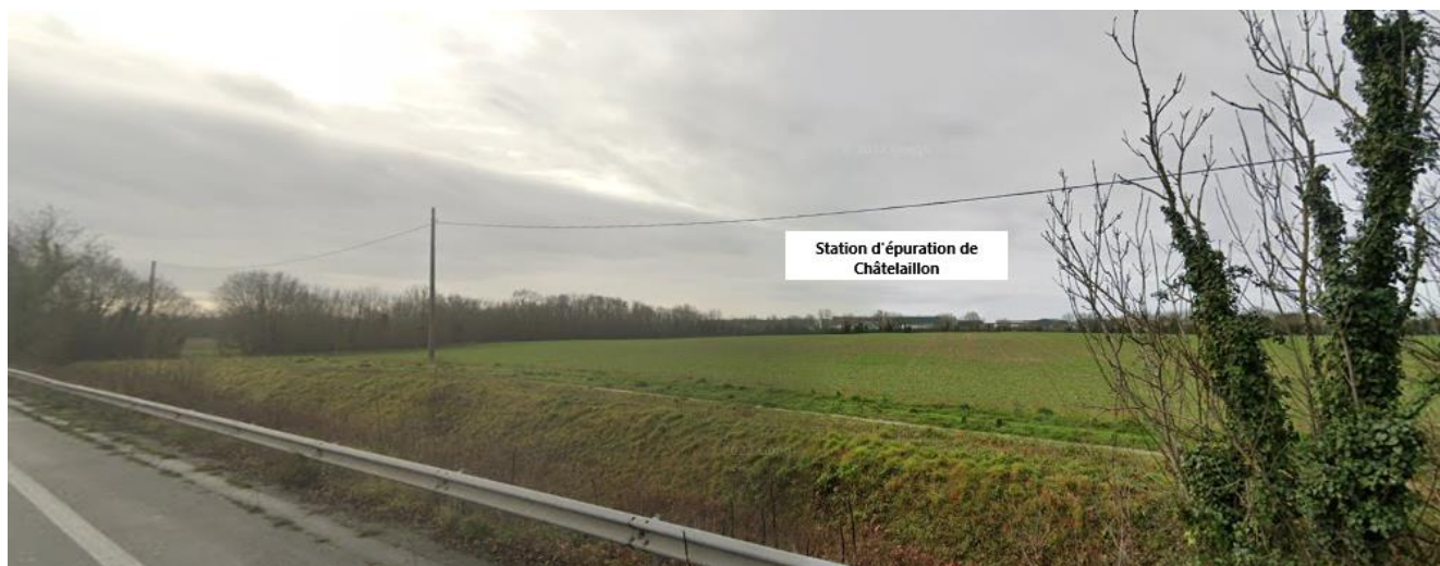
Figure 29 : Photographies de la station d'épuration depuis la RD 137 (Source : Google Maps)
